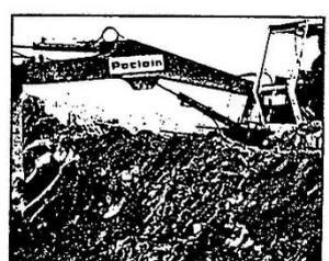
4 - Pour donner aux flancs un profil dressé on peut travailler face au talus et utiliser le dos du godet pour tasser et lisser la terre, qui doit être assez humide.
