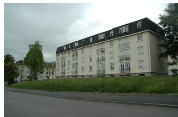
Des opérations de bâtis collectifs d'ensemble
