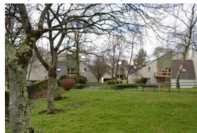
Foyer Logement (résidence autonomie)
