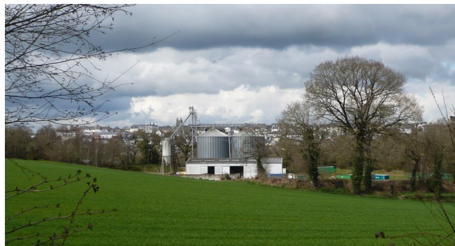
Centrale à chaux située au Nord du périmètre
