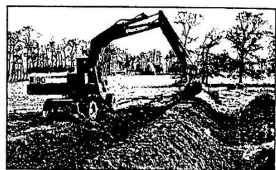
3 - Si l'on veut un travail de qualité, il est préférable de remodeler le nouveau talus à la pelleuse ou au tracto-pelle, travail à exécuter lorsque l'humidité est suffisante.
