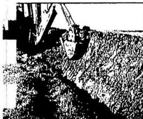
5 - Ce godet à fossés, au profil tassé, permet aussi un tassement énergique et un lissage des flancs du talus. Le lissage s'effectue de haut en haut.
