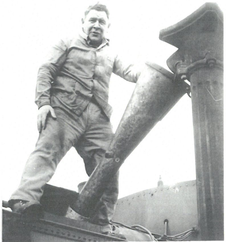
Remplissage du caisson à eau à la prise d'eau.
