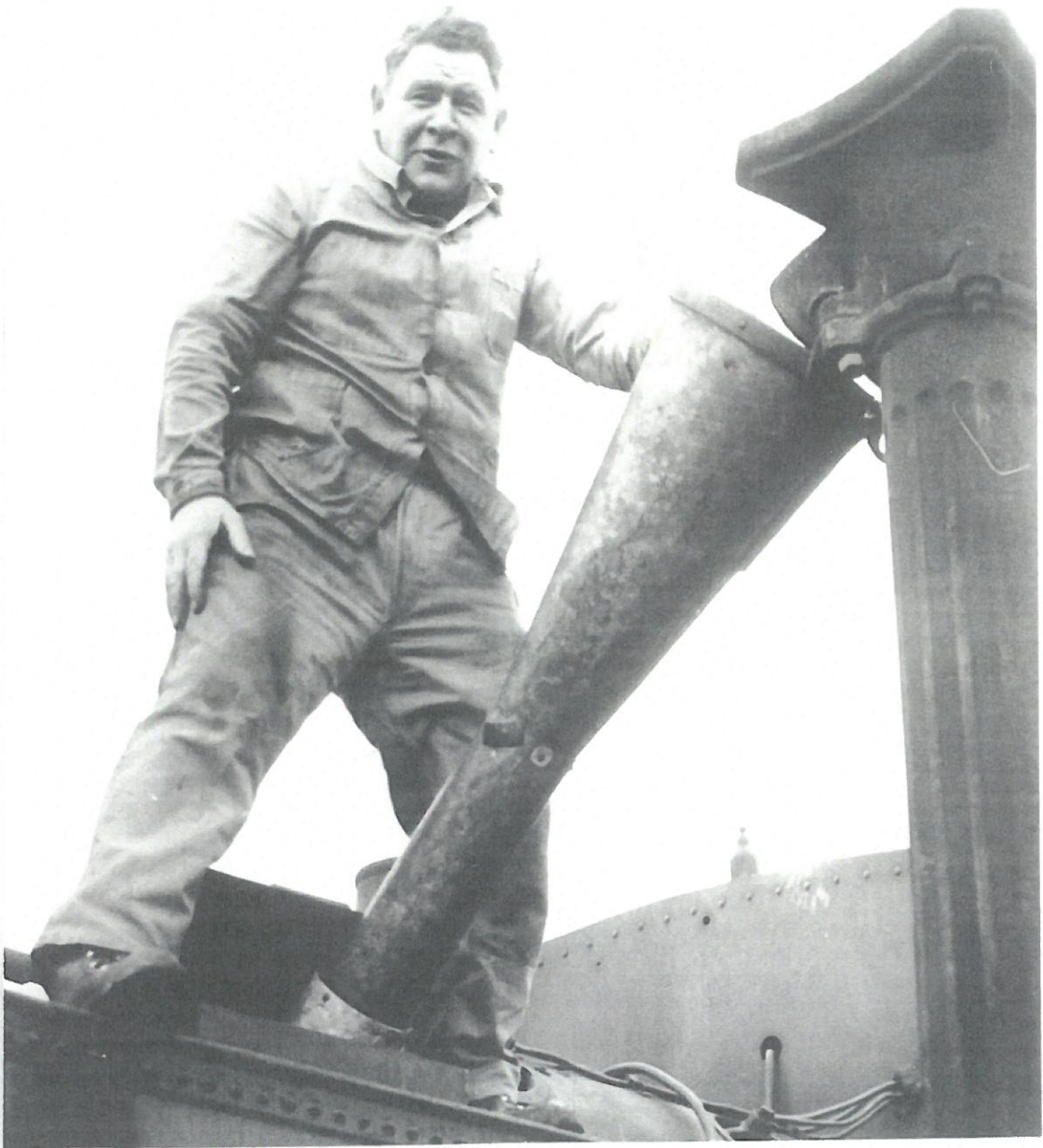
Remplissage des caisses à eau "la prise d'eau."
